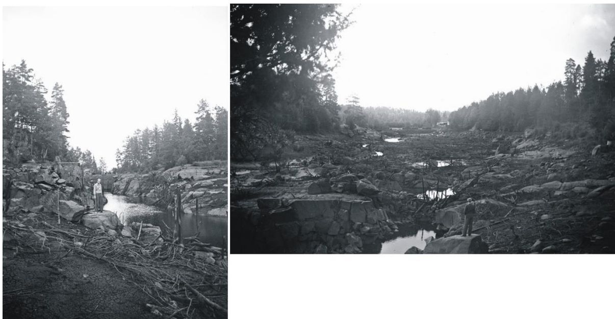
Figur 10. Äldre foton från Brännebro. Till vänster ett fotografi ned emot dammvallen från 1930-talet, vilket visar vattennivån vid begränsad dämning och höjden uppströms i förhållande till dammen. Till höger samma tillfälle men med uppströmsvy.
