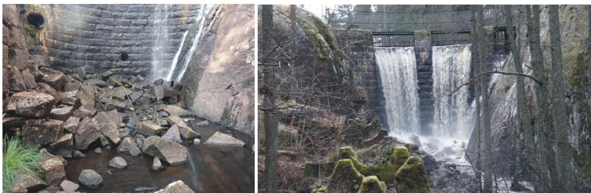
Figur 8. Området omedelbart nedströms dammvallen. Fotografiet till vänster förhållanden vid mycket låg tillrinning och till höger vid hög tillrinning. Blocken är helt säkert ända från då dammkroppen skapades 1914-15, som resultat av de sprängningar som verkar ha förekommit (Fig 10)
