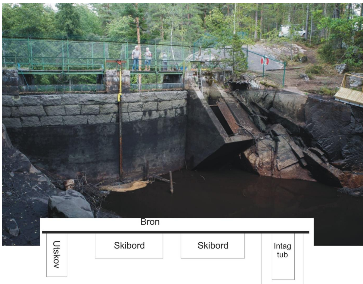
Figur 11. Dämnet sett uppifrån vid nedtappning av dammen sommaren 2018. Under finns en skiss över de fyra möjliga "utskov" som finns.
